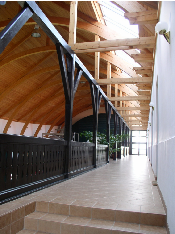
Régi borház tornáca helyreállítva
